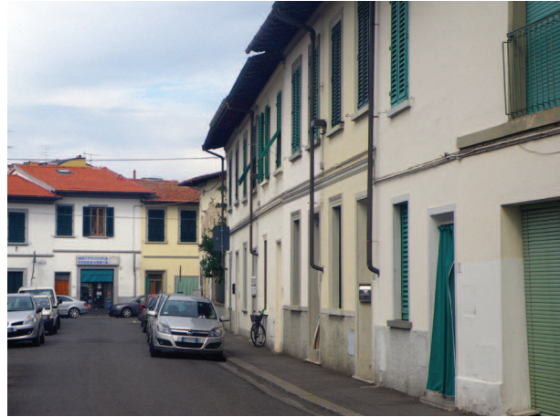
Fig. II.2-16. Caso studio della zona omogenea 5.: edifici storici lungo via del Palazzo dei Diavoli.
