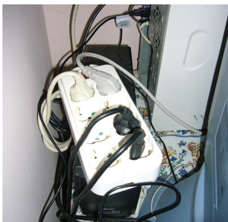
Fig. I.3- 22 L'uso di prese multiple e ciabatte aumenta il rischio di sovraccarico delle prese con relativo rischio di incendio.
