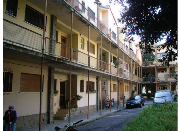
Fig. II.2-8. Caso studio della zona omogenea 1.: case plurifamiliari singole a ballatoio esterno in via delle Camelie.
