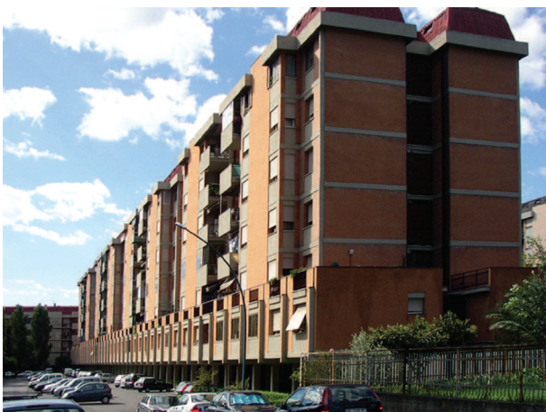
Fig. II.2-11. Caso studio della zona omogenea 2.: caseggiati popolari in linea, via dell'Argin Grosso.
