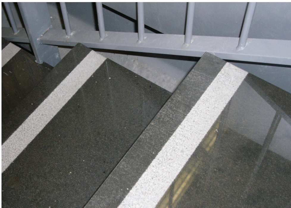
Fig. 17 Particolare della lavorazione del bordo del rivestimento del grado di una scala della Fiera di Milano-Rho progettata da Massimiliano Fuksa. (Archivio Valli)
