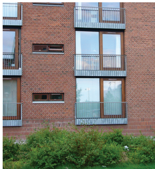
Fig. 54 Esempi di parapetti di finestre a tutta altezza con parte inferiore non apribile che funge da parapetto (a sinistra) e di portafinestre, con parapetto esterno di protezione (a destra). (Archivio Valli)
