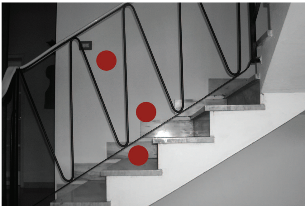
Fig. 28 Nelle scale condominiali, il parapetto delle scale deve essere inattraversabile, in ogni sua parte, da una sfera di 10 cm di diametro; la sua altezza deve essere di almeno 100 cm. (Archivio Lauria)
