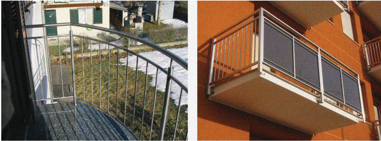
Fig. 86 Esempi di ringhiere che, seppur conformi al requisito di inattraversabilità previsto dalla normativa (vedi Scheda 4. p.to 4.1.4), presentano varchi tra traverso orizzontale inferiore e pavimento che consentono il passaggio e la caduta nel vuoto di oggetti di piccole dimensioni. (Archivio Bacchetti)
