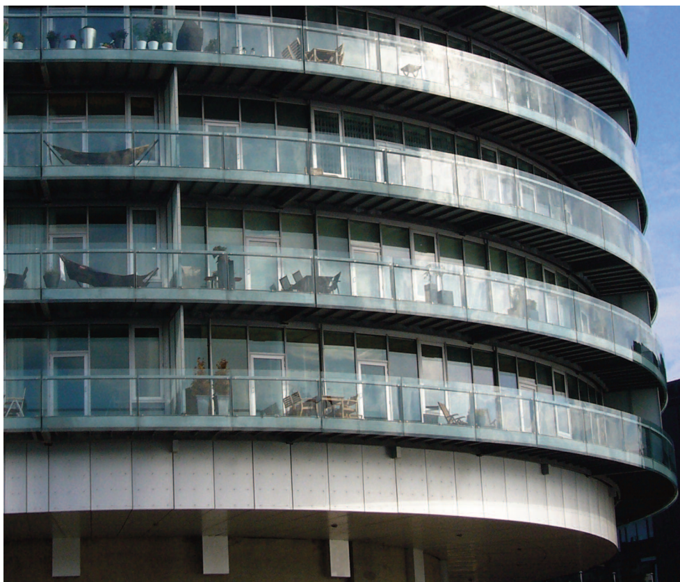
Fig. 85 Parapetto di tipo continuo privo di soluzioni di continuità in corrispondenza del piano di calpestio di un balcone. (Archivio Valli)
