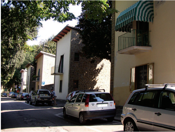
Fig. II.2-7. Caso studio della zona omogenea 1.: case unifamiliari con alloggi sovrapposti in via degli Oleandri.
