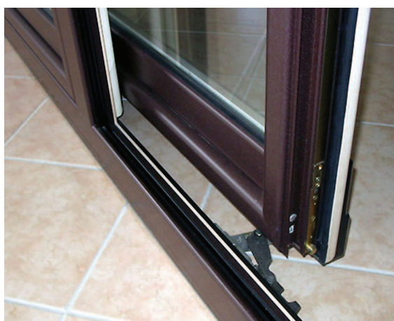
Fig. 48 Le traverse a pavimento delle portefinestre possono causare cadute da inciampo e costituiscono elemento di ostacolo per le persone su sedia a ruote.
